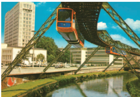
Fig. 8 - C.p.i. 5600 Wuppertal - Schwebebahn, fără editor, circulată în anul 1989
